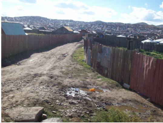
写真 5：二つの敷地の塀に挟まれている道路
