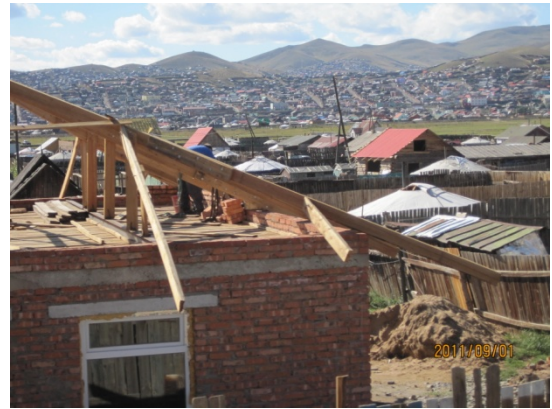
写真 8：ゲル地区における建設途中のレンガ造の新築物。屋根は木造
