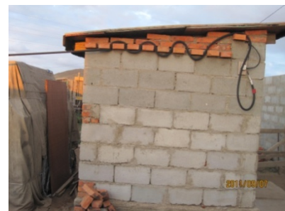
トイレの建物 (出典：上野研究室)
