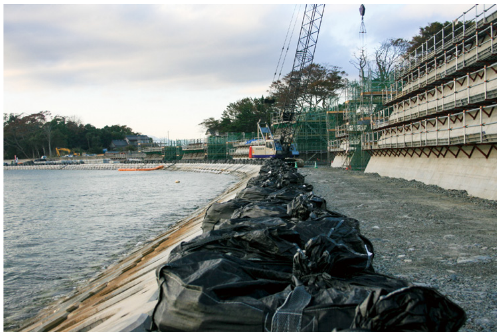
海側から撮影、磯が20m埋め立てられました。
